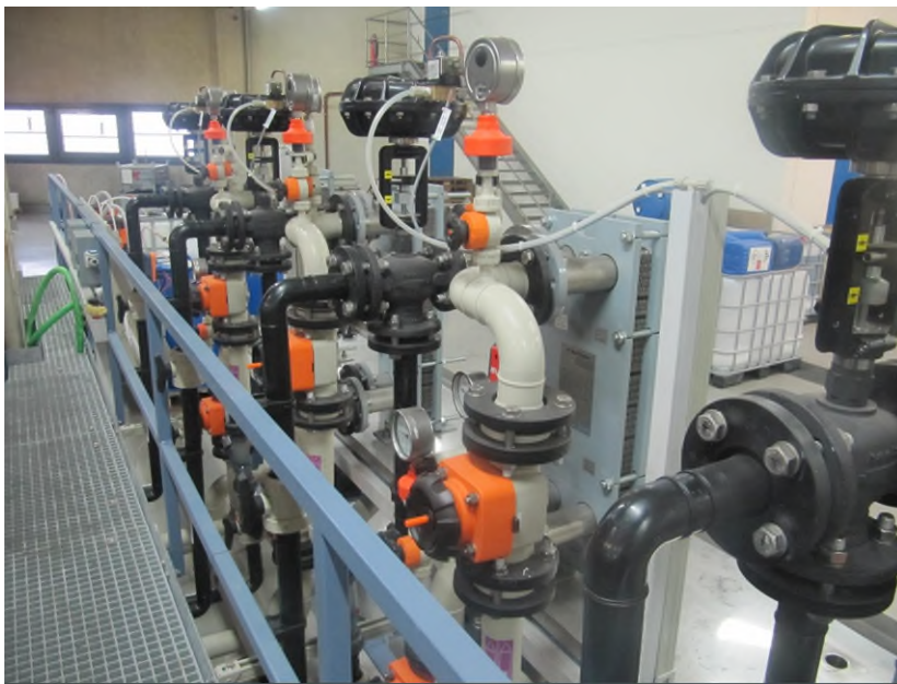
Abb. 20: Bühne zur sicheren Wartung und Instandhaltung von Nebenaggregaten
