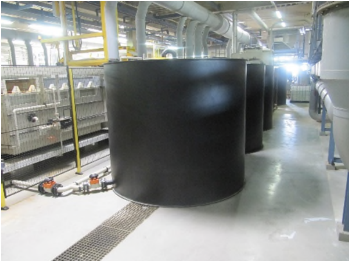
Abb. 22: Sammelbehälter mit Rückhalteeinrichtung in der Abwasserbehandlung
