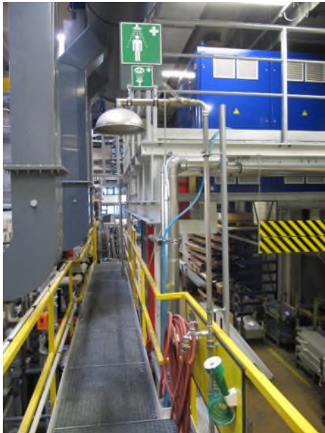
Abb. 19: Erste Hilfe-Einrichtungen – Notdusche und Augendusche deutlich gekennzeichnet
