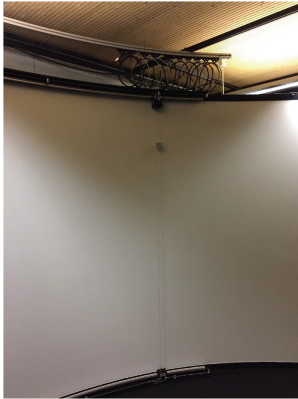
Abbildung 4.2-4: Laufschiene vor / an der Projektionsleinwand
