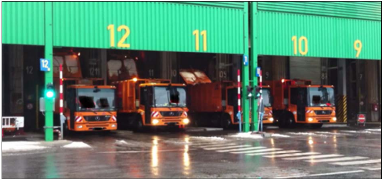
Abbildung 5-26. Beispiel für die räumliche Enge bei paralleler Entladung mehrerer Fahrzeuge an benachbarten Ladetoren
