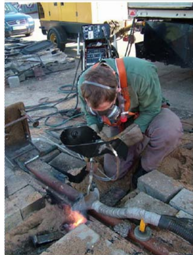
Schweißen von Schienenstößen
