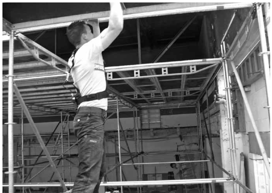
Abbildung B.33: Montage des Gerüstes
