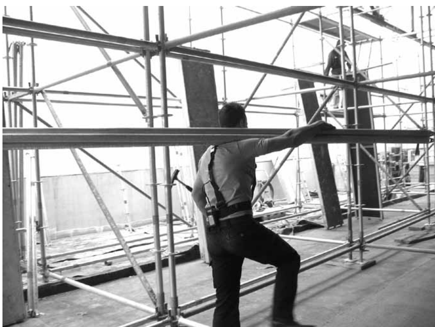
Abbildung B.32: Gerüstteile transportieren
