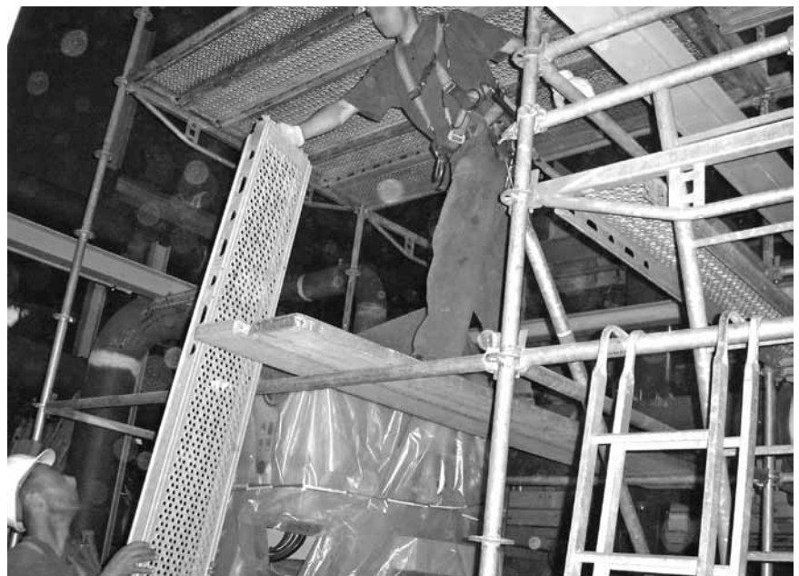
Abbildung B.25: Gerüstteile zureichen
