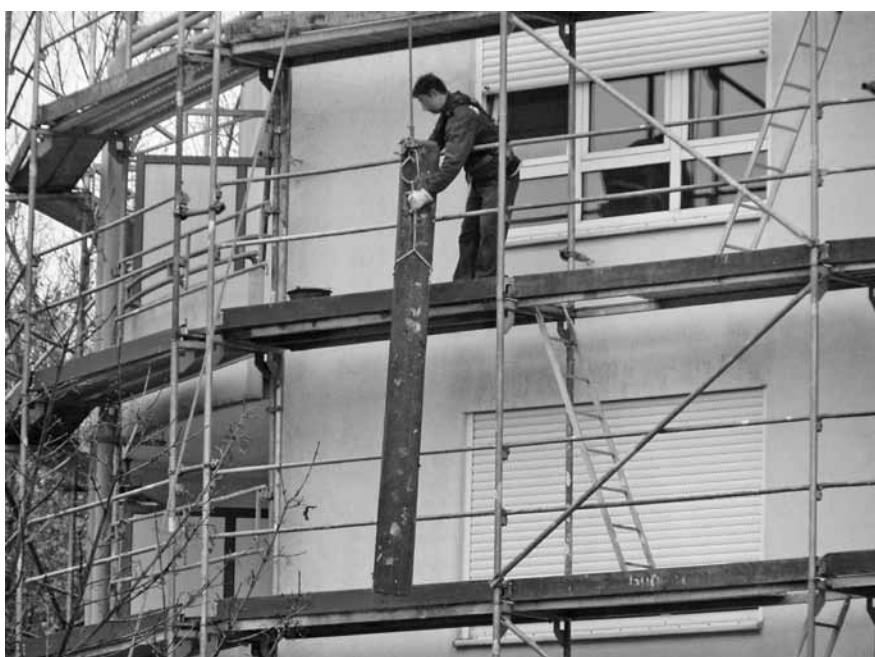
Abbildung B.22: Abrüsten mit Seilwinde
