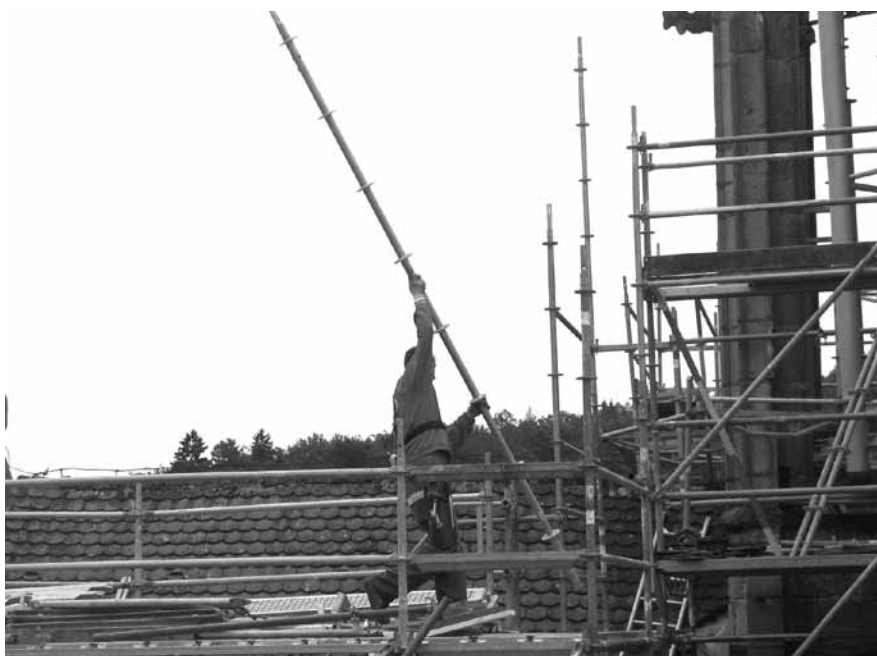
Abbildung B.42: Gerüstaufbau
