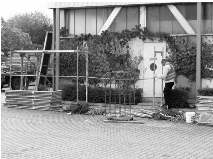
Abbildung B.17: Erste Gerüstlage erstellen
