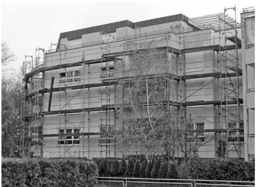
Abbildung B.6: Baustelle 6
