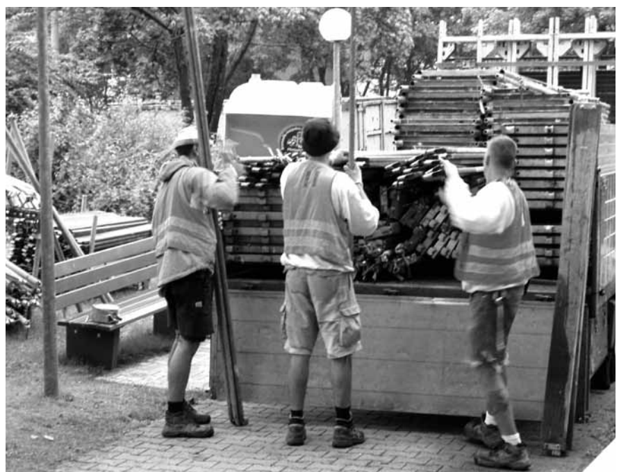
Abbildung B.16: Gerüstteile vom Lkw abladen
