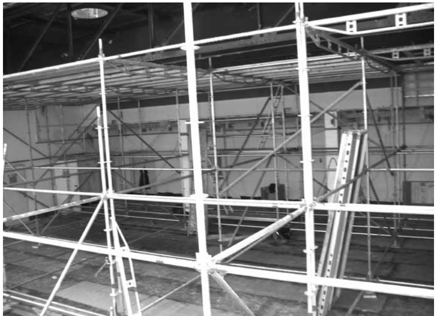
Abbildung B.10: Baustelle 11
