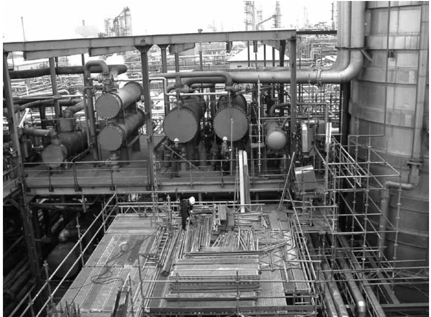
Abbildung B.9: Baustelle 10
