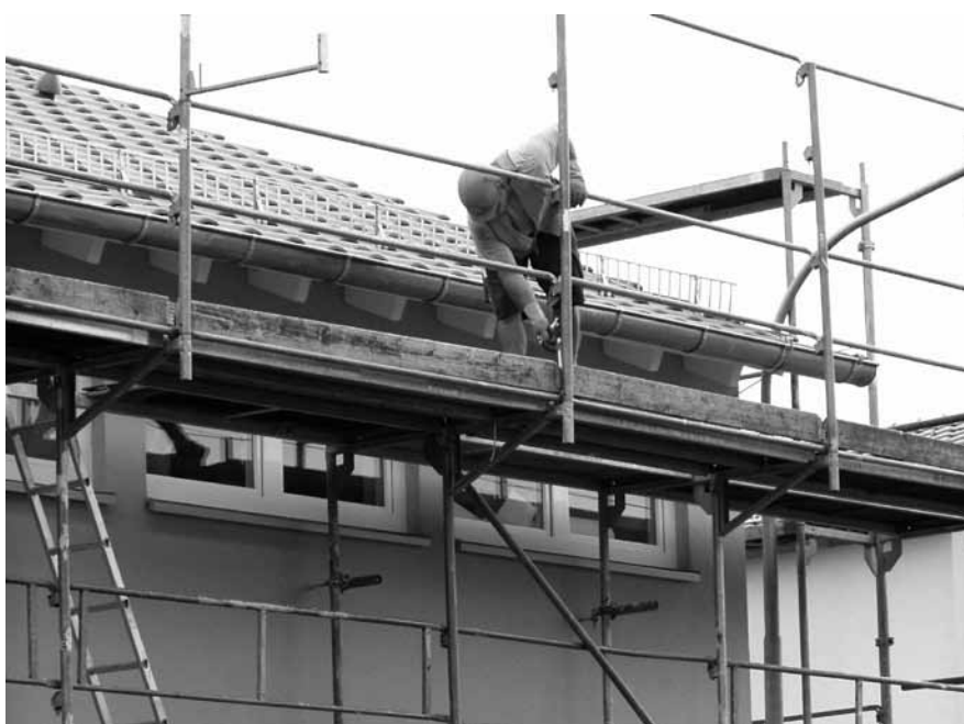
Abbildung B.19: Gerüstabbau
