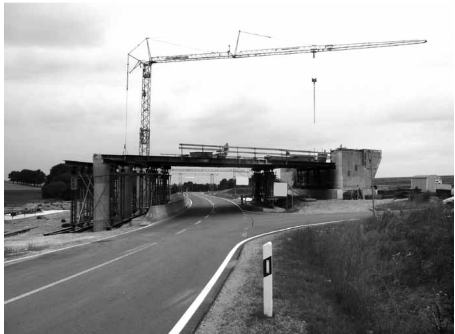
Abbildung B.15: Baustelle 17
