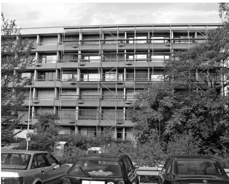
Abbildung B.4: Baustelle 4
