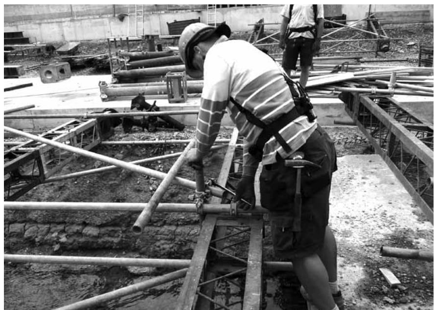
Abbildung B.43: Stützen am Boden vormontieren
