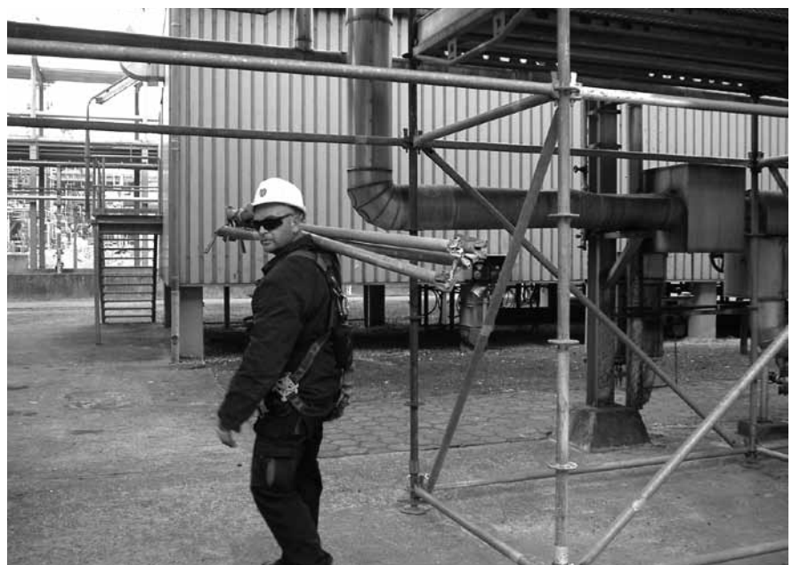
Abbildung B.29: Gerüstteile transportieren
