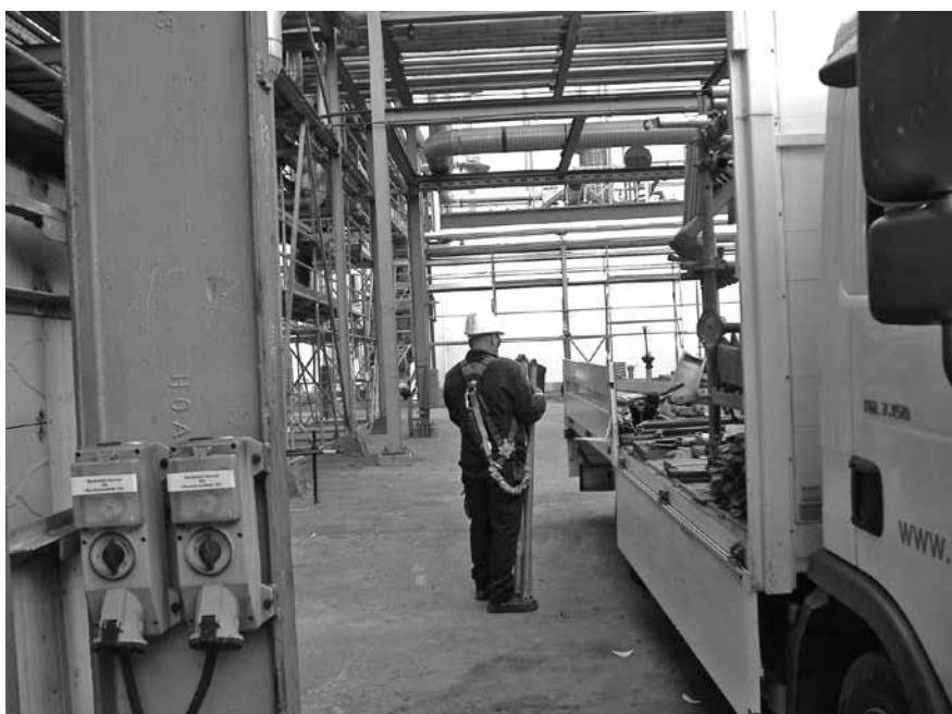
Abbildung B.28: Gerüstteile transportieren
