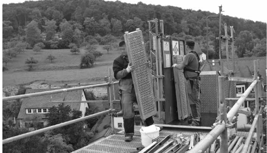
Abbildung B.41: Aufzug entladen
