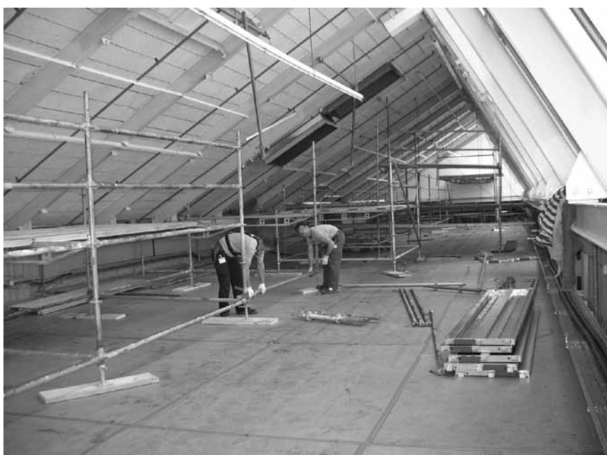
Abbildung B.36: Gerüstumbau
