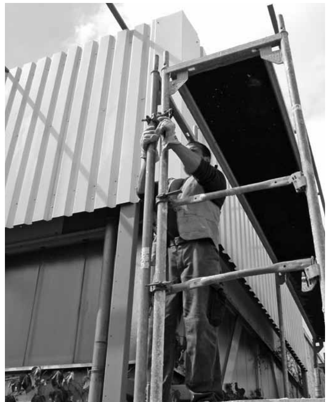
Abbildung B.18: Gerüstteile verschrauben
