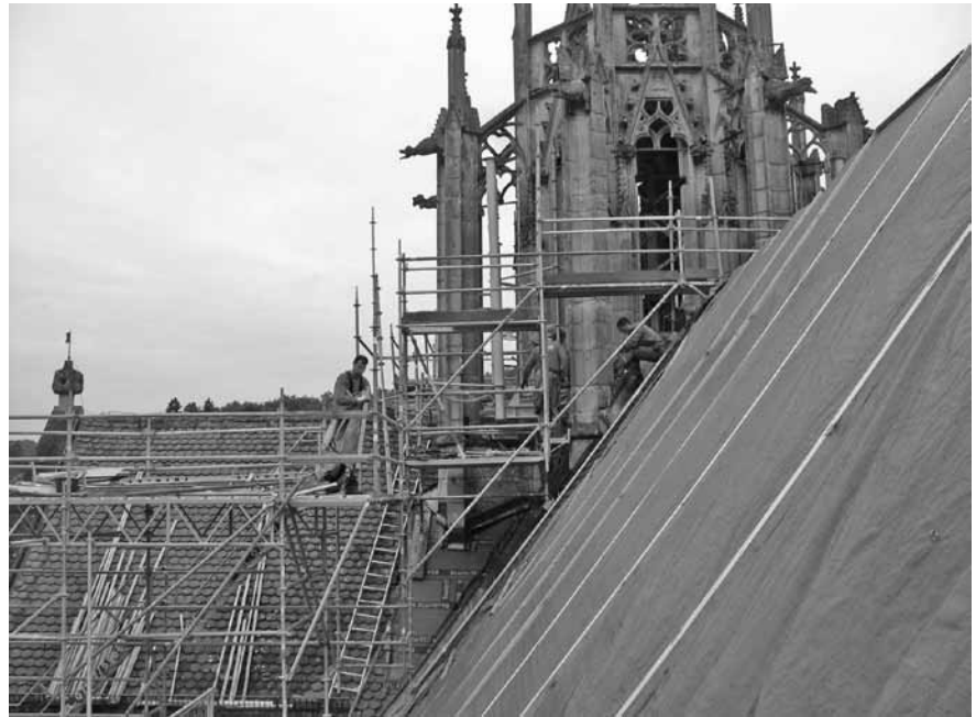
Abbildung B.14: Baustelle 16
