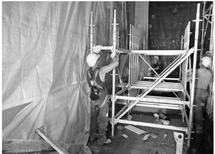
Abbildung B.27: Modulgerüst demontieren
