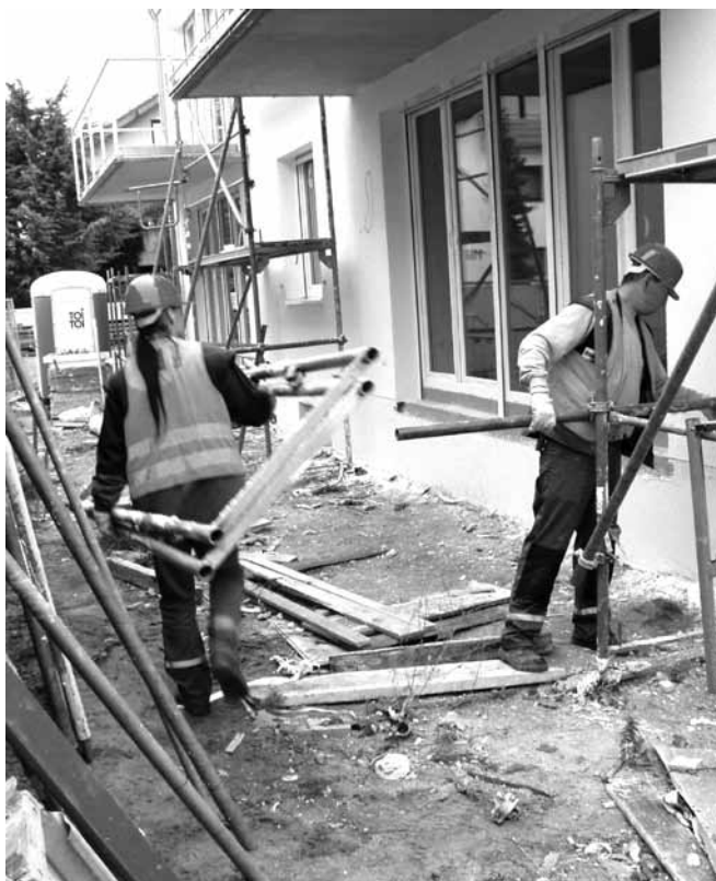
Abbildung B.20: Gerüstabbau
