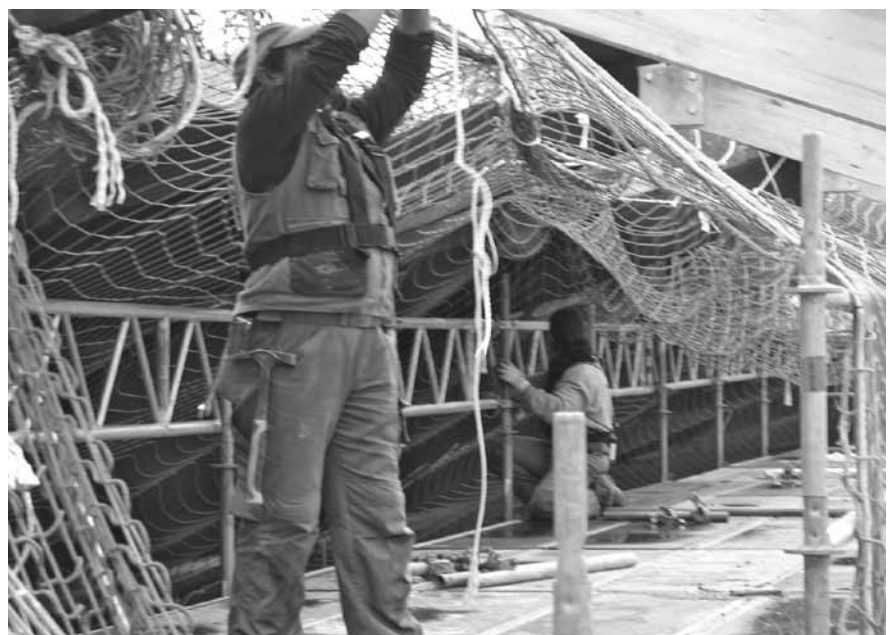
Abbildung B.37: Abbau der Netze
