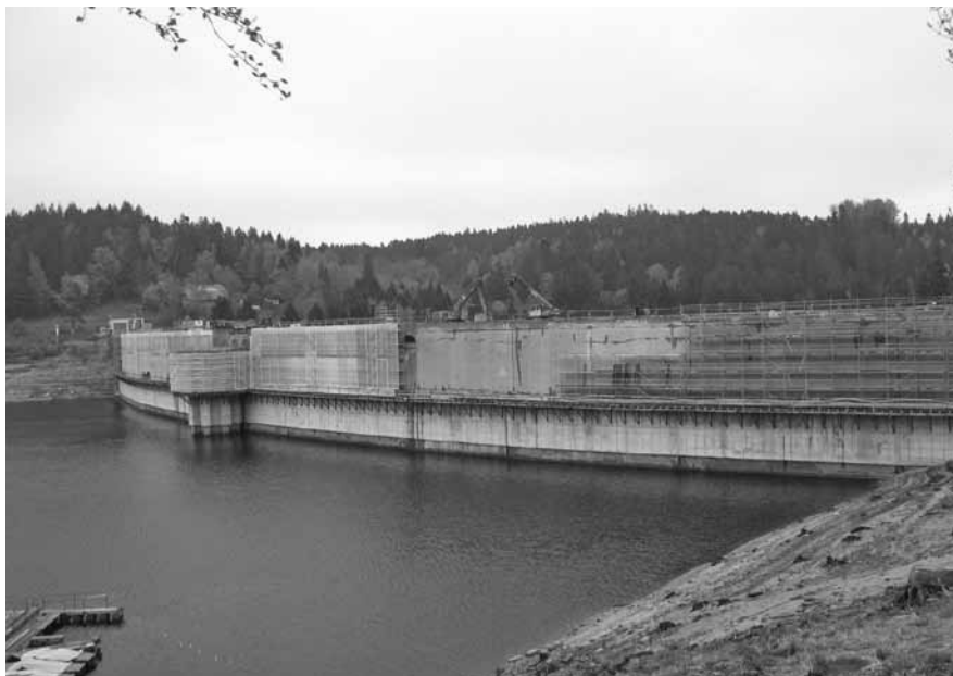
Abbildung B.11: Baustelle 12
