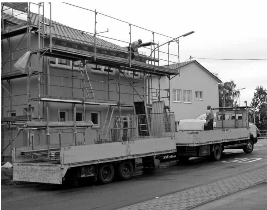
Abbildung B.3: Baustelle 3
