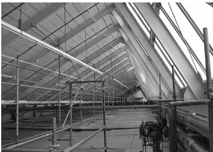
Abbildung B.12: Baustelle 13
