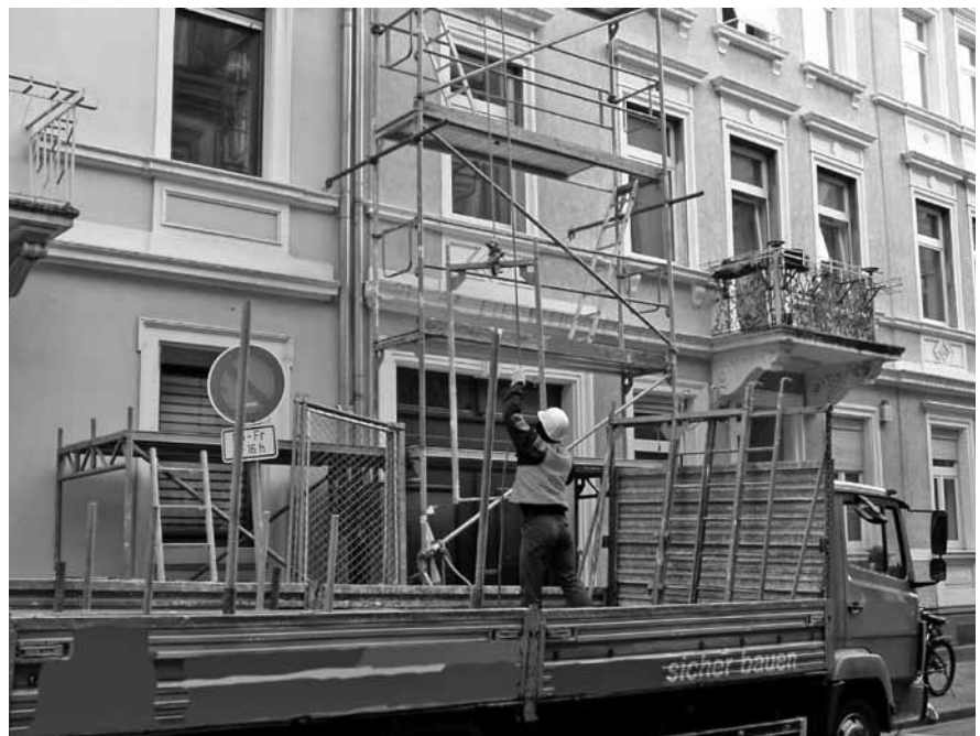
Abbildung B.24: Gerüstteile verladen
