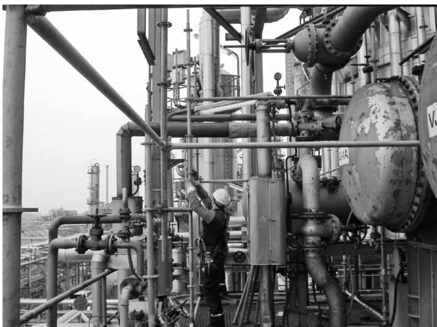
Abbildung B.30: Gerüstteile montieren
