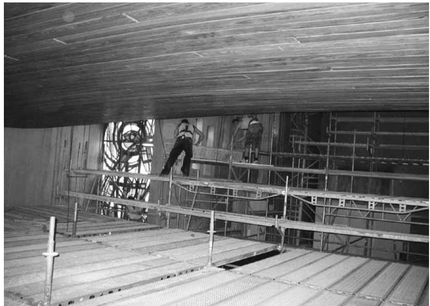
Abbildung B.39: Gerüstlagen transportieren und einlegen
