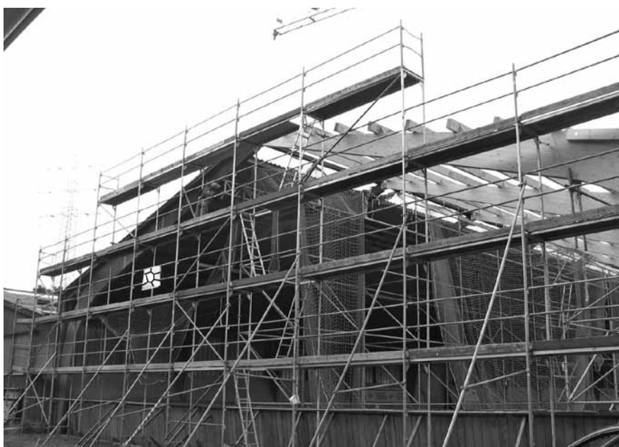
Abbildung B.13: Baustelle 14
