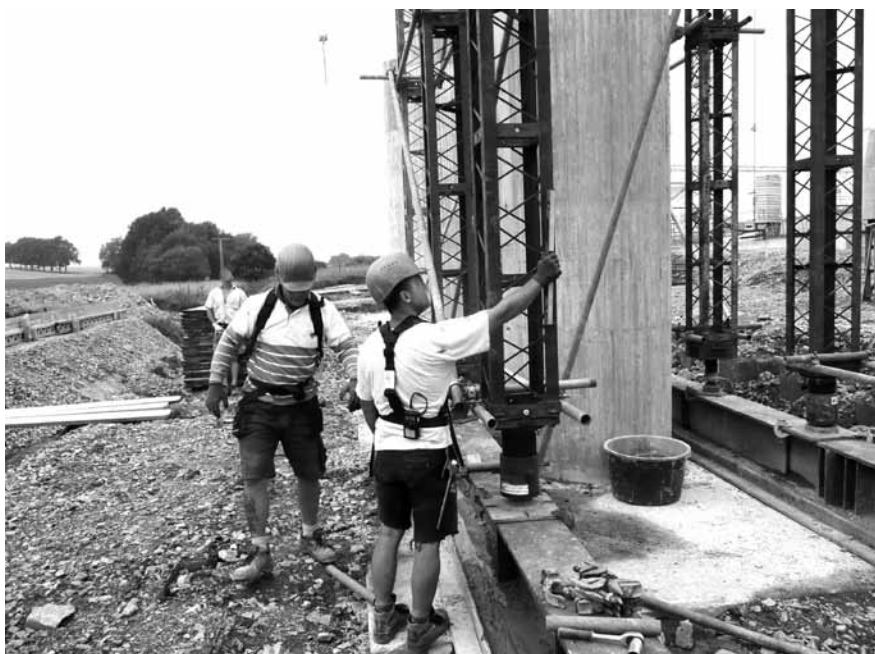
Abbildung B.44: Traggerüst ausrichten
