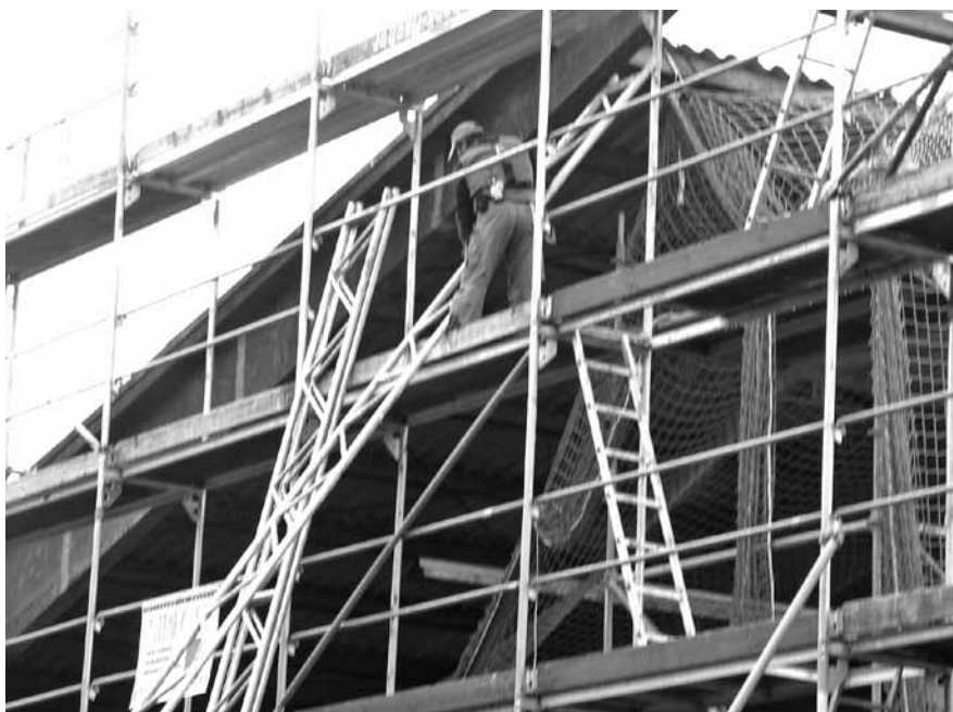
Abbildung B.38: Gerüstabbau
