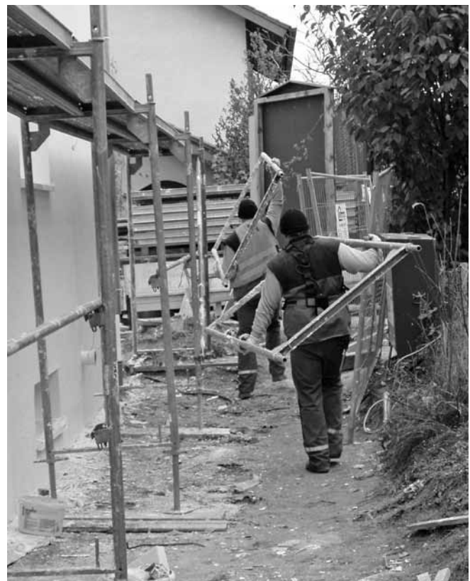
Abbildung B.21: Gerüstteile transportieren
