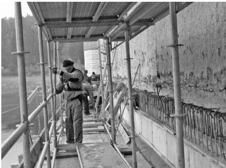
Abbildung B.34: Gerüstaufbau
