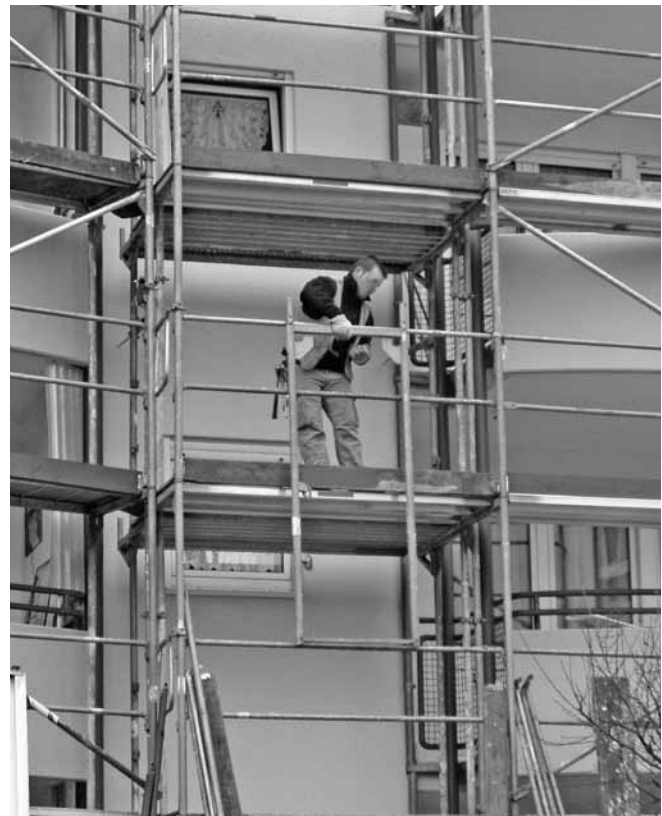
Abbildung B.23: Baugerüst abbauen
