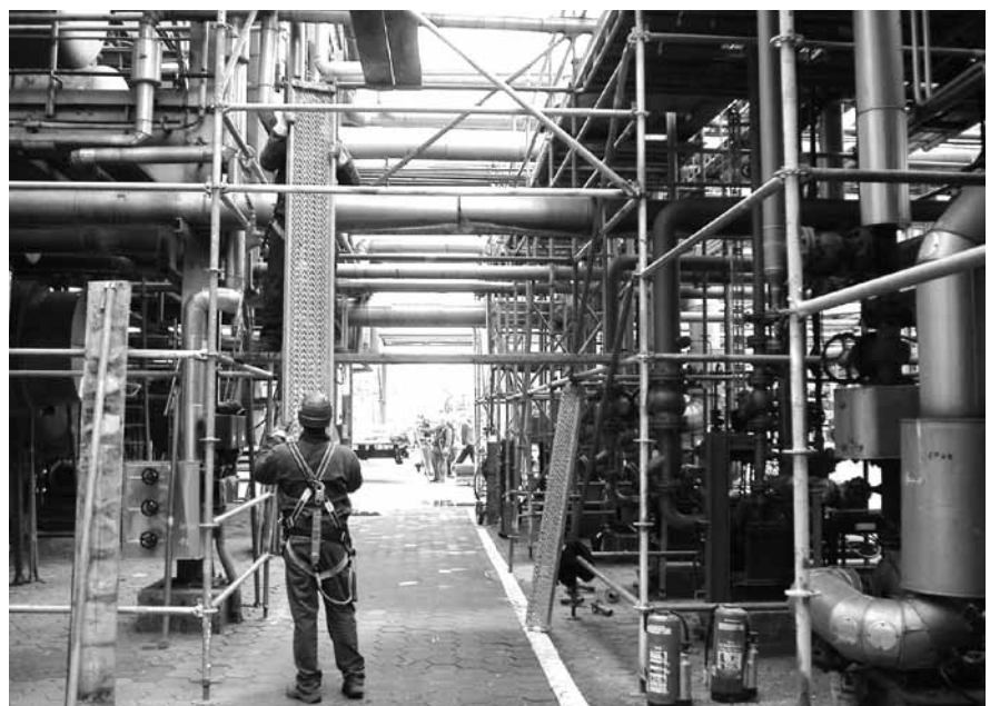
Abbildung B.31: Gerüst abbauen
