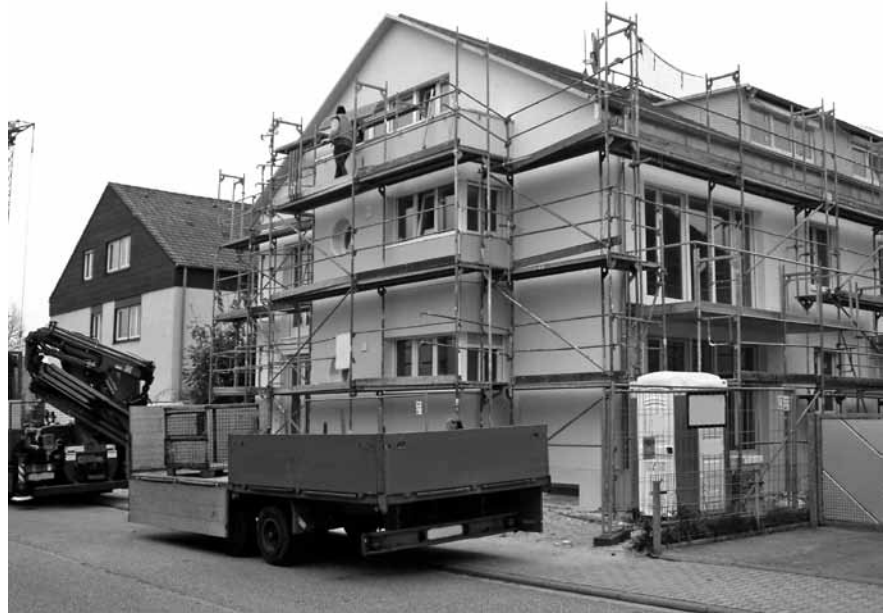
Abbildung B.5: Baustelle 5
