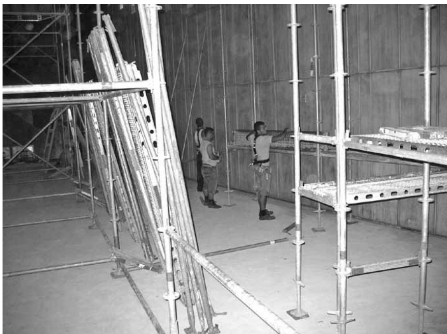
Abbildung B.40: Standgerüst aufbauen
