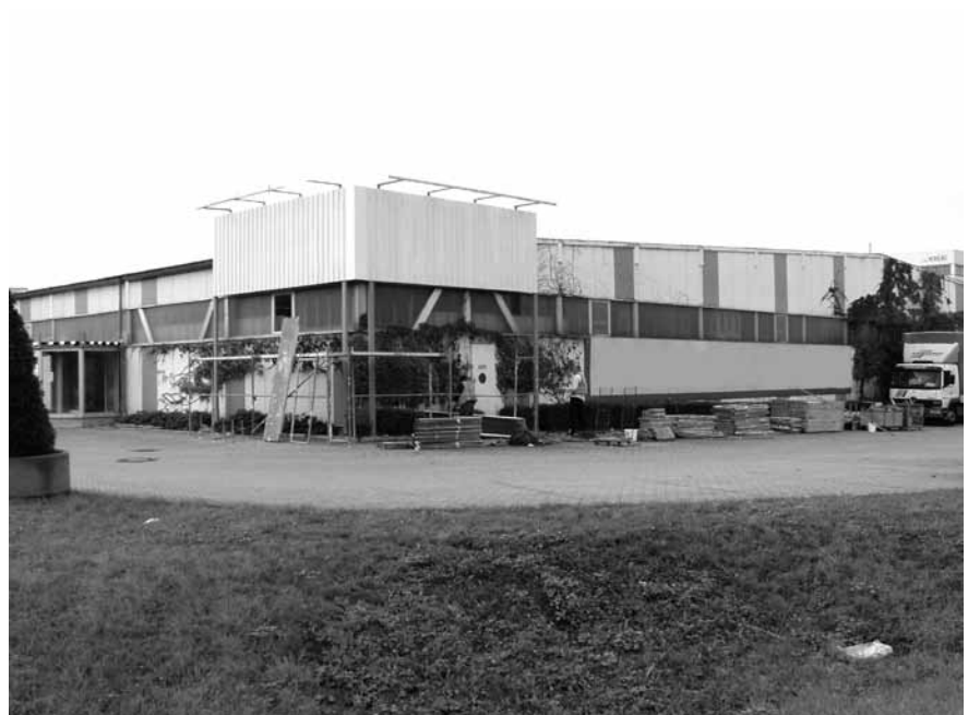
Abbildung B.2: Baustelle 2
