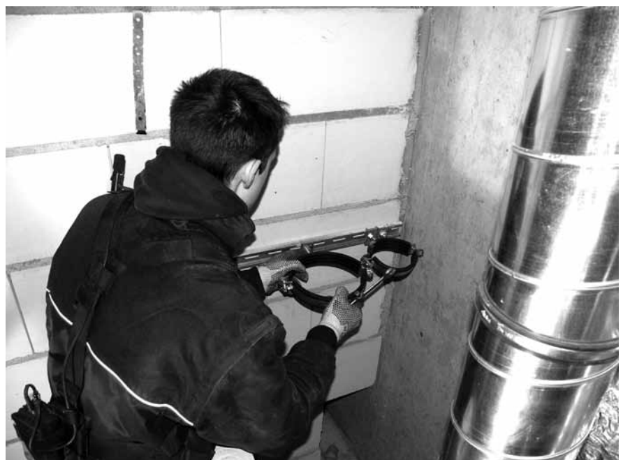
Abbildung A.27: Rohrschellen montieren
