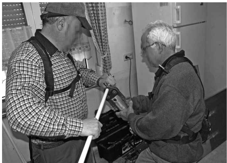
Abbildung A.15: Zusammen mit einem Kollegen GFK-Heizungsrohre verpressen
