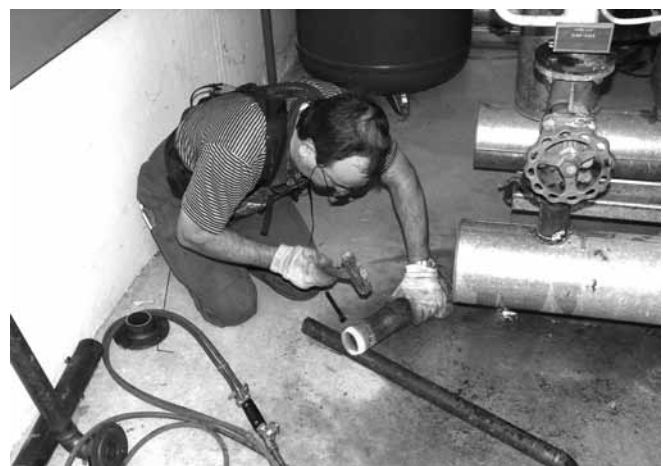
Abbildung A.33: Heizungsrohr erhitzen
