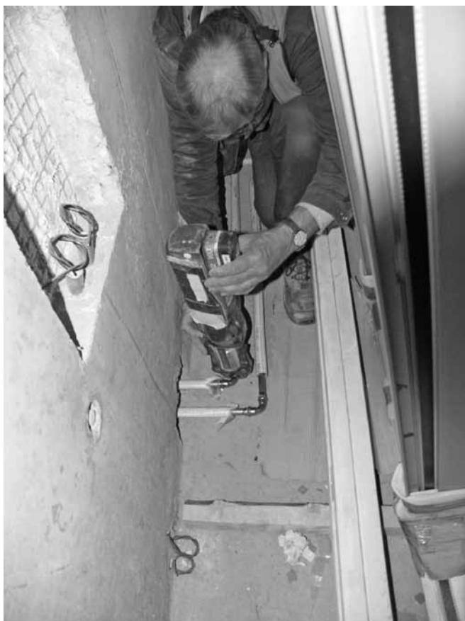
Abbildung A.12: Heizungsrohre verpressen
