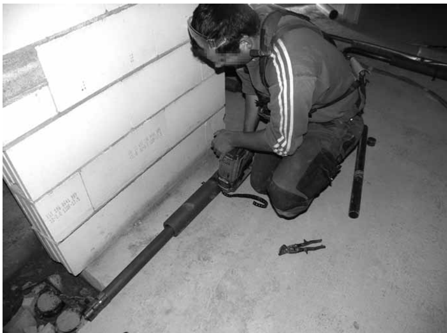
Abbildung A.18: Rohre mit Impulsnagler festsetzen
