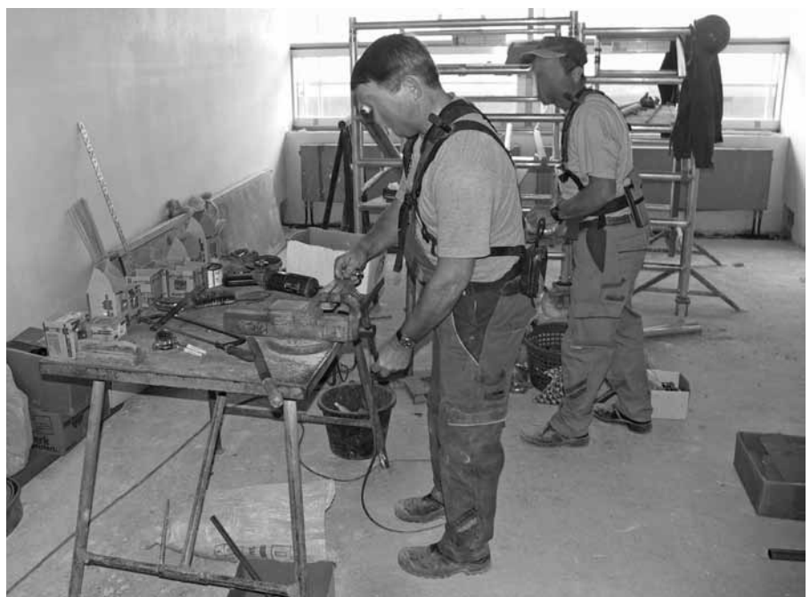
Abbildung A.19: Gewindestangen an der Werkbank vorbereiten
