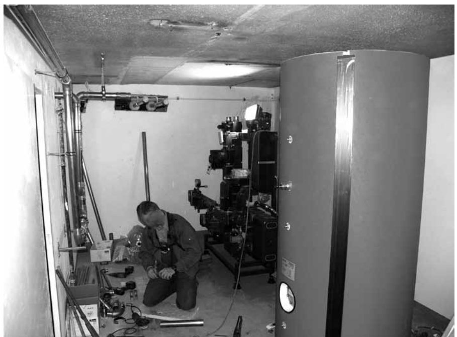
Abbildung A.25: Heizungsrohre vorbereiten
