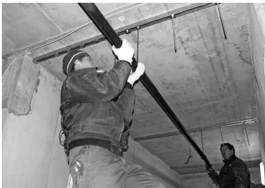
Abbildung A.30: Zusammen mit einem Kollegen Heizungsrohre montieren
