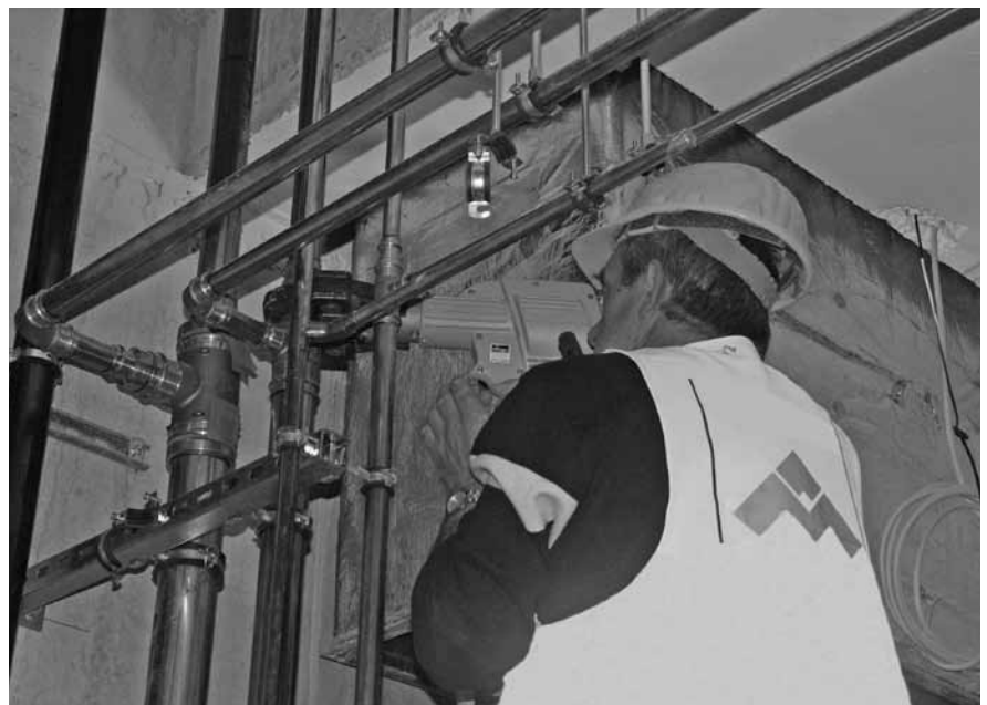
Abbildung A.13: Versorgungsrohre verpressen
