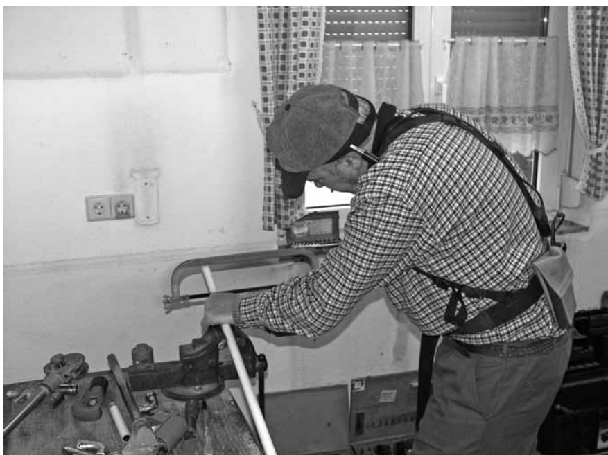
Abbildung A.16: GFK-Heizungsrohr sägen
