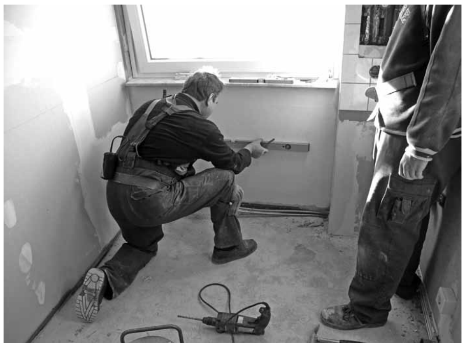
Abbildung A.21: Bohrlöcher für die Montage der Heizkörperhalterungen anzeichnen
