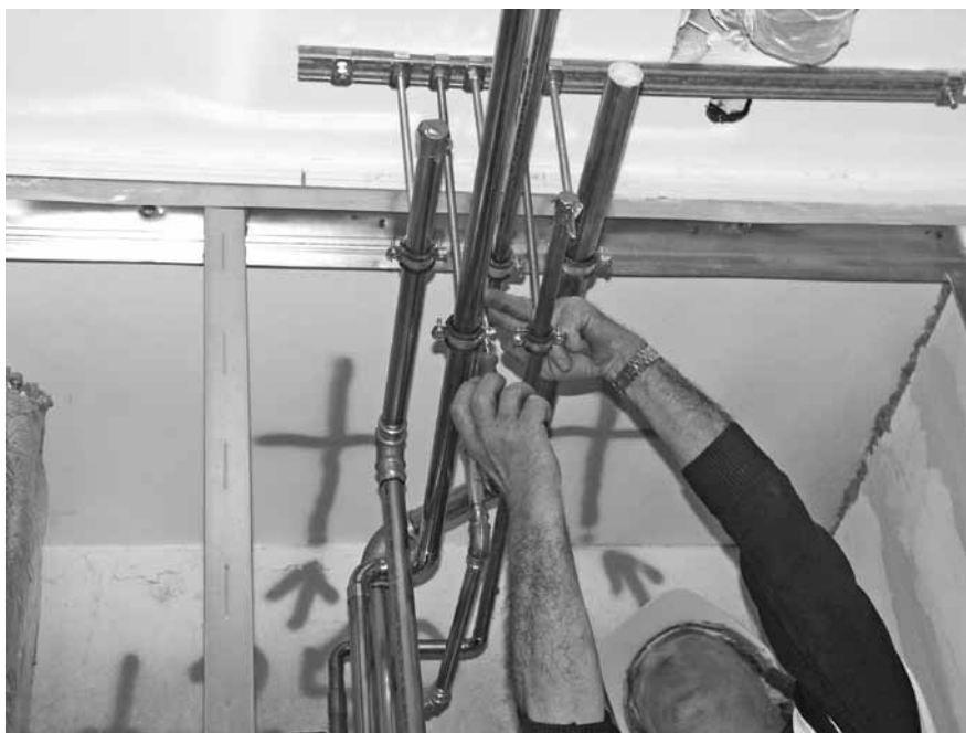
Abbildung A.14: Versorgungsrohre montieren
