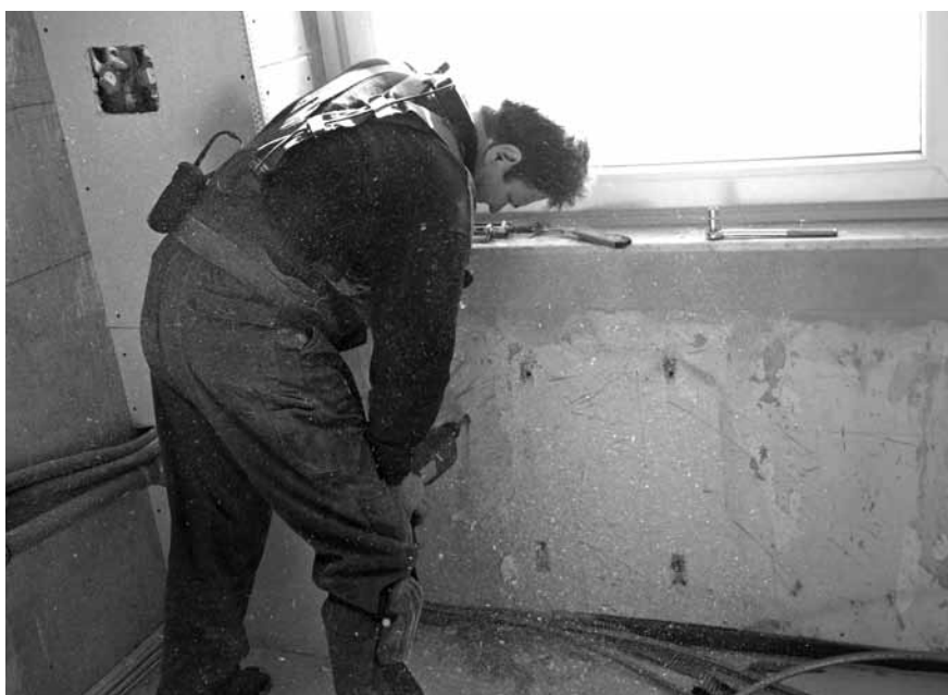
Abbildung A.24: Löcher für Halterungen bohren
