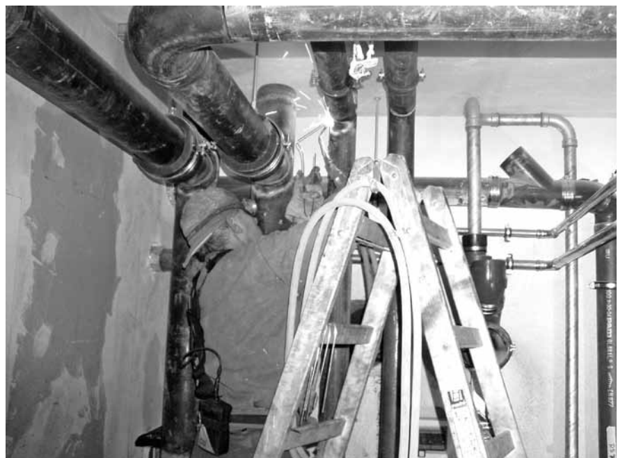
Abbildung A.35: An Heizungsrohren schweißen
