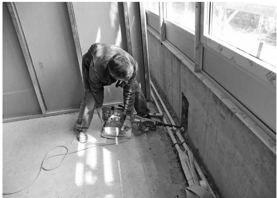
Abbildung A.11: Stemmarbeiten an Betonwand
