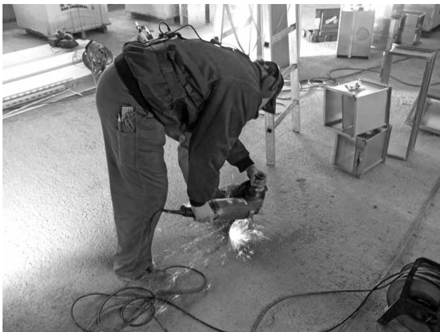
Abbildung A.28: Abwasserrohr mit Winkelschleifer kürzen
