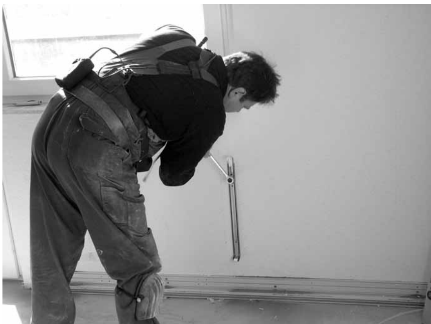
Abbildung A.22: Heizkörperhalterungen montieren
