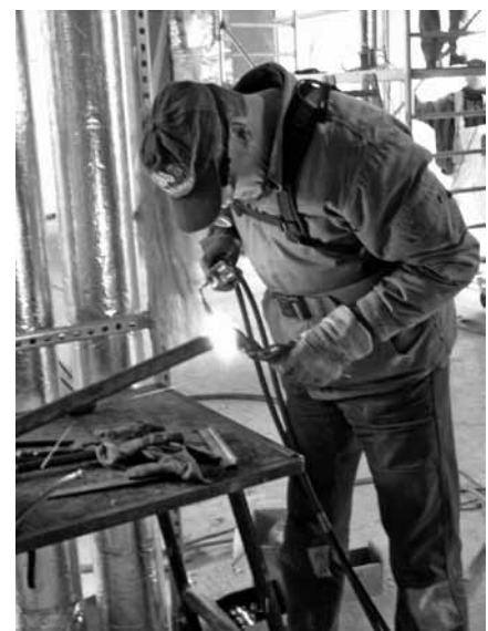
Abbildung A.36: 90°-Bogen an Heizungsrohr anschweißen
