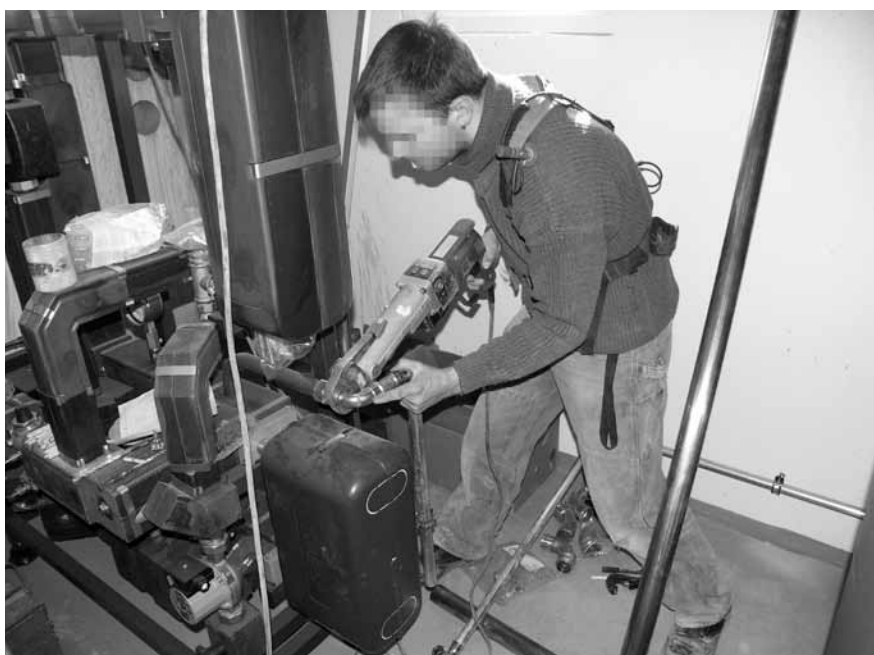
Abbildung A.26: Fittings mit Presszange verpressen
