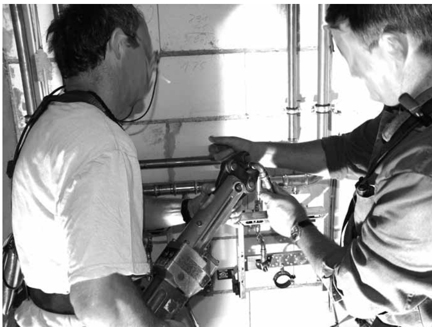
Abbildung A.20: Kupferrohr mit Fitting verpressen
