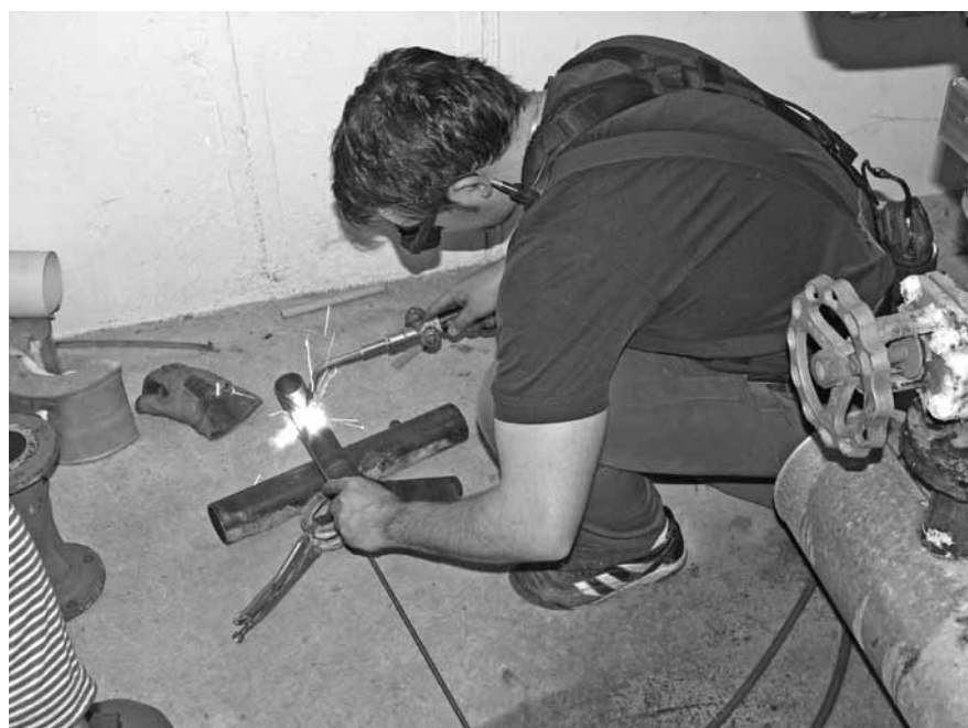
Abbildung A.34: Neues Bogenstück schweißen
