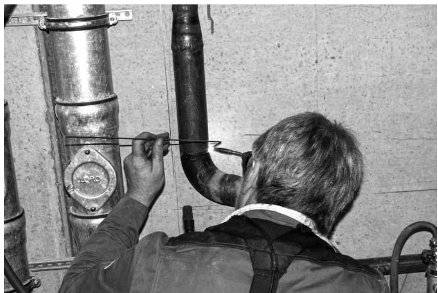
Abbildung A.31: Gasleitung hartlöten
