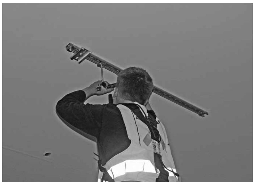
Abbildung A.9: Rohrschellen montieren
