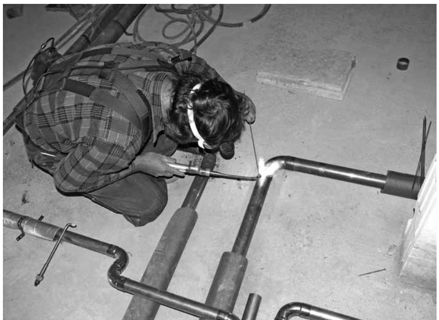
Abbildung A.17: Hartlöten von Versorgungsleitung
