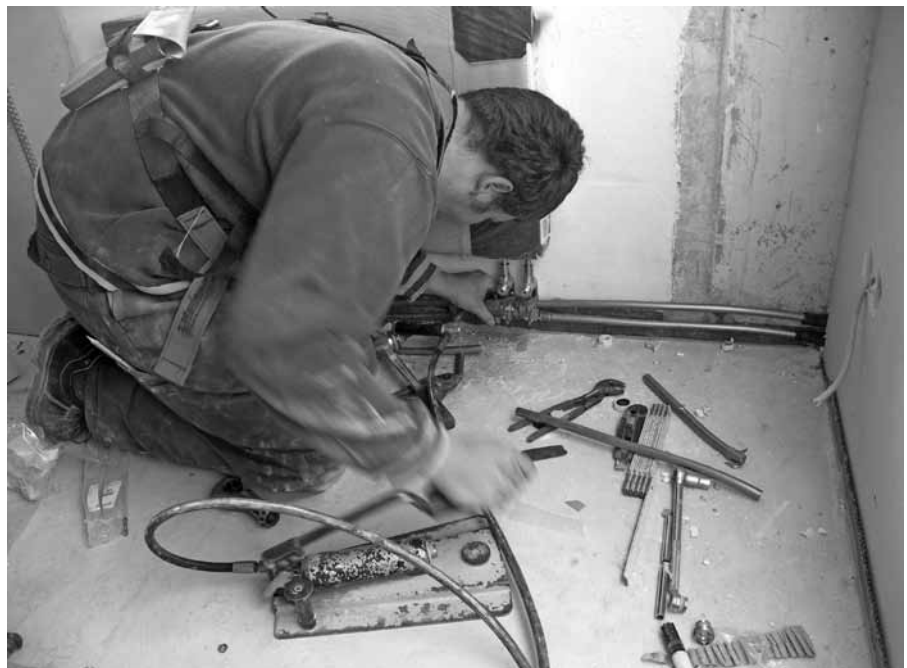
Abbildung A.23: Heizungsrohre verpressen
