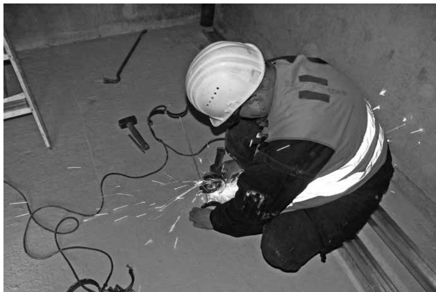
Abbildung A.10: Gewindestangen schneiden
