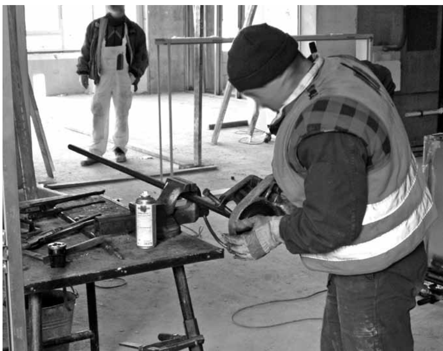
Abbildung A.37: Gewinde auf Heizungsrohr schneiden
