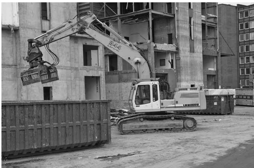
Abbildung C.16: Bagger mit Sortiergreifer bedienen
