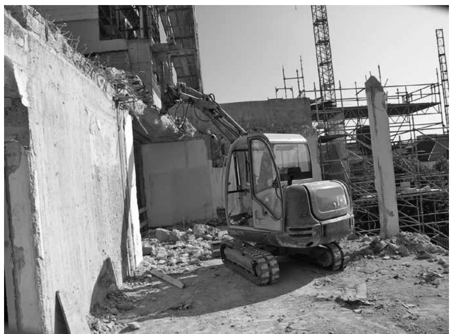
Abbildung C.8: Abbruch mit Minibagger
