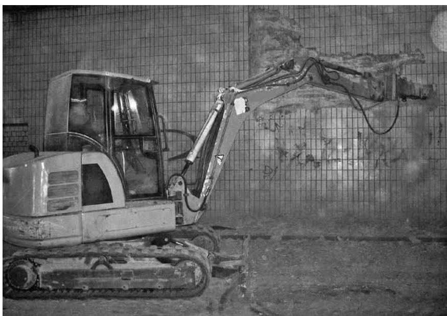
Abbildung C.20: Abbruch der Fliesen mit Minibagger
