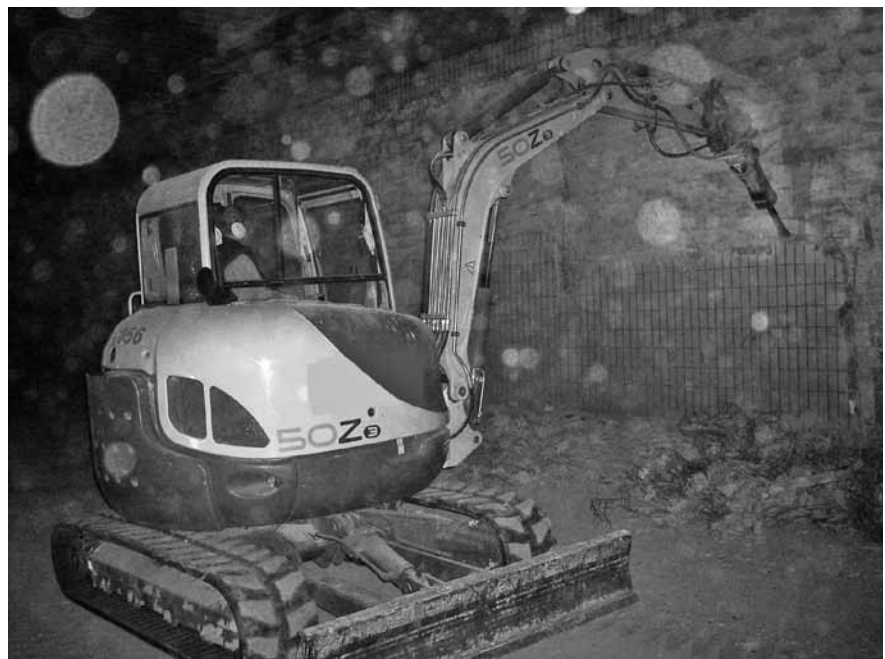
Abbildung C.21: Abbruch der Fliesen mit Minibagger
