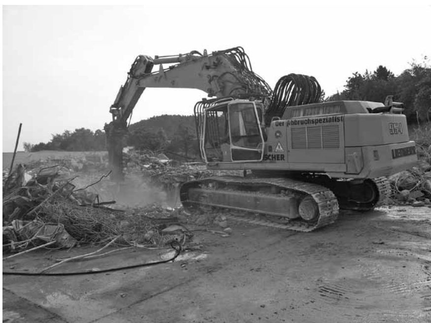
Abbildung C.9: Abbruch mit Bagger
