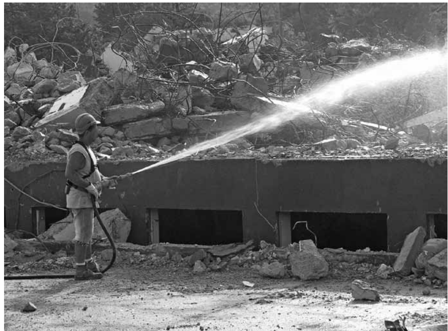
Abbildung C.10: Mit Wasserschlauch spritzen
