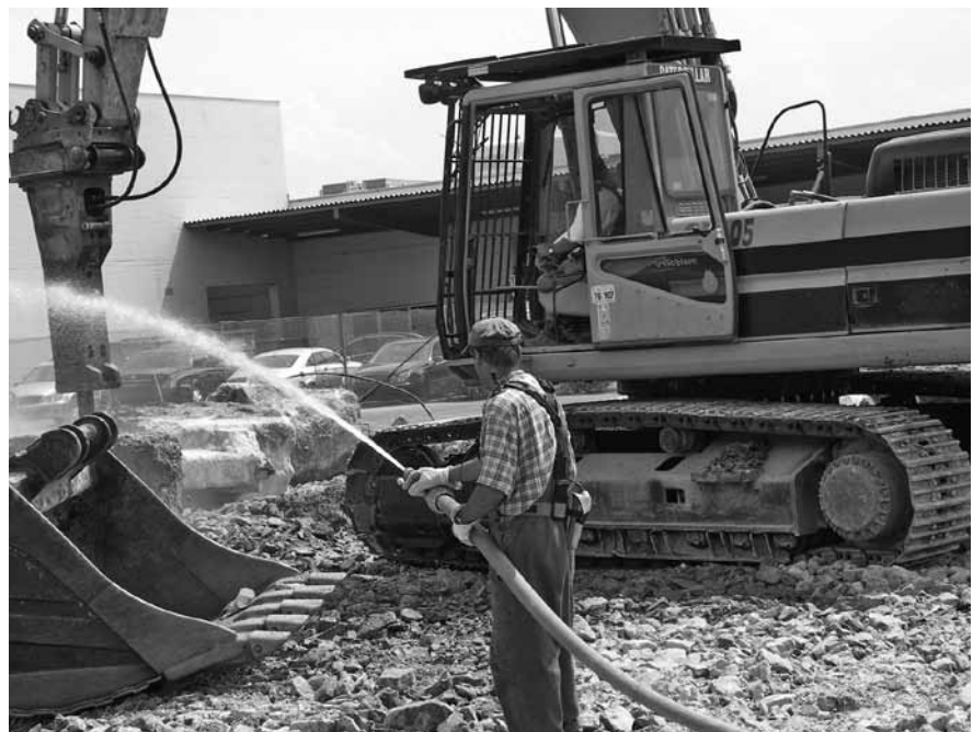
Abbildung C.12: Mit Wasserschlauch spritzen
