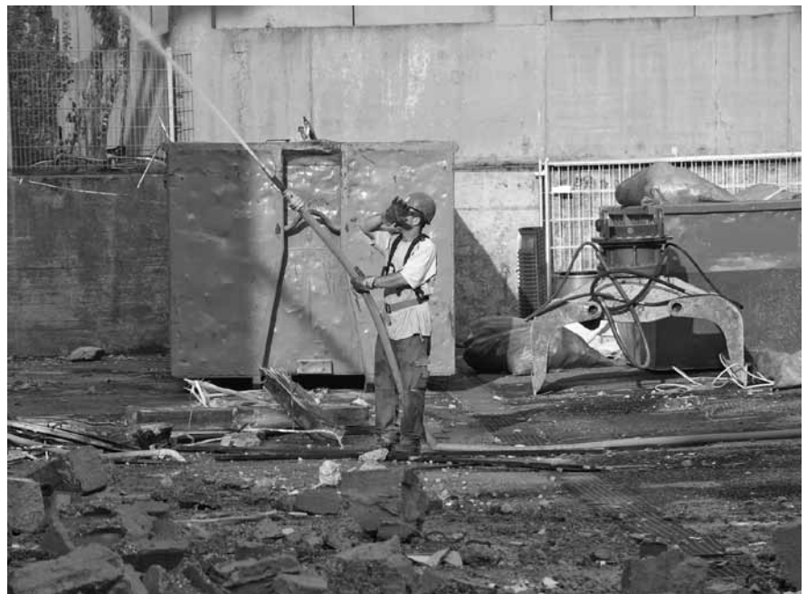
Abbildung C.14: Mit Wasserschlauch spritzen
