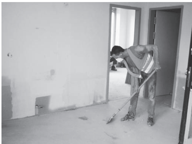
Abbildung C.7: Estrich mit Bodenstripper bearbeiten
