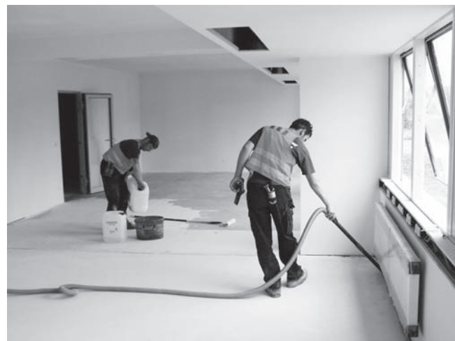
Abbildung C.19: Estrich mit Industriesauger absaugen
