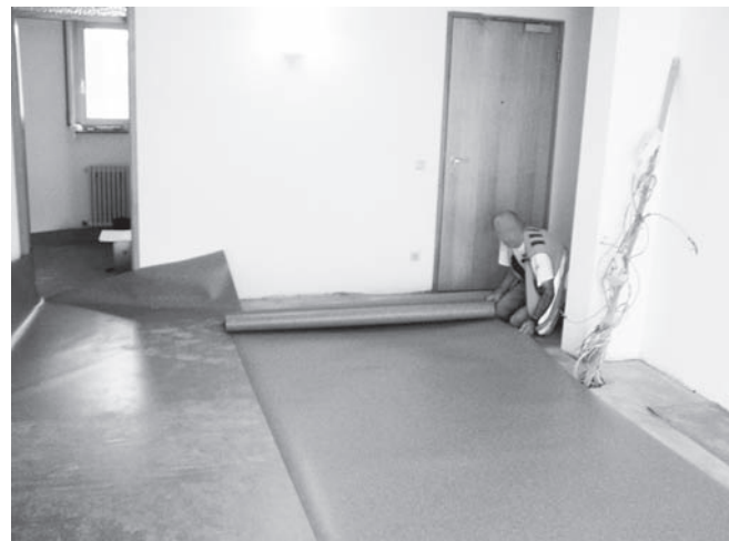
Abbildung C.14: PVC-Boden verlegen
