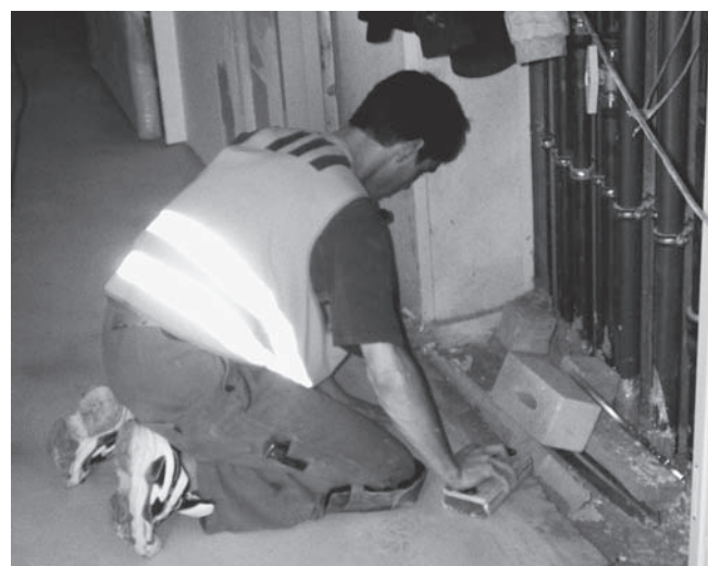
Abbildung C.6: Estrich mit Handschleifklotz abschleifen
