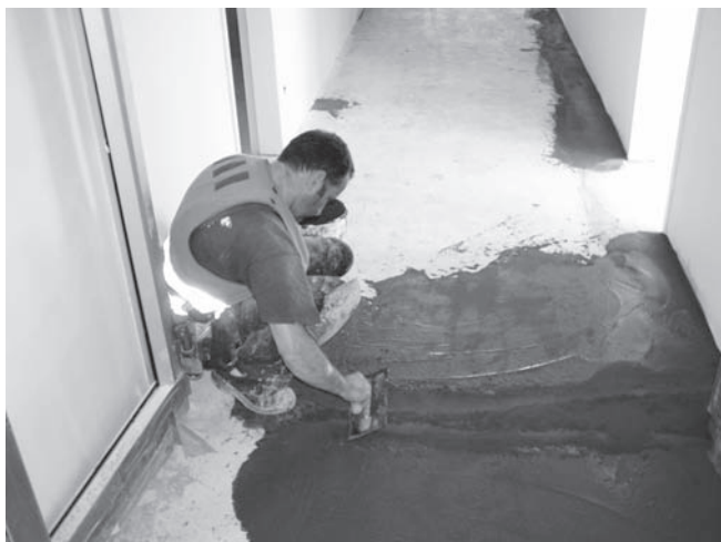
Abbildung C.18: Ausgleichsmasse auftragen
