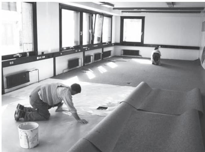
Abbildung C.17: Kleber auftragen
