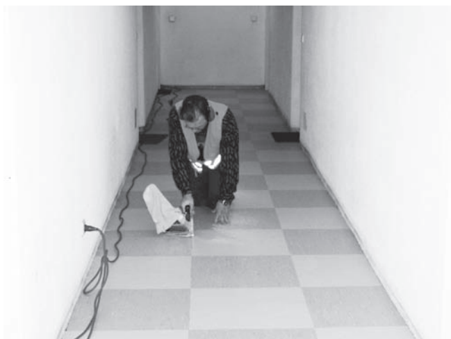
Abbildung C.11: Stoßkanten der PVC-Platten fräsen
