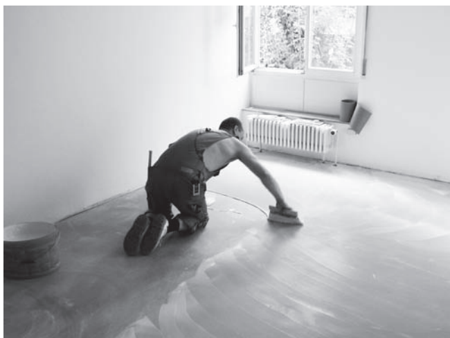
Abbildung C.13: Kleber mit Zahnpachtel auftragen
