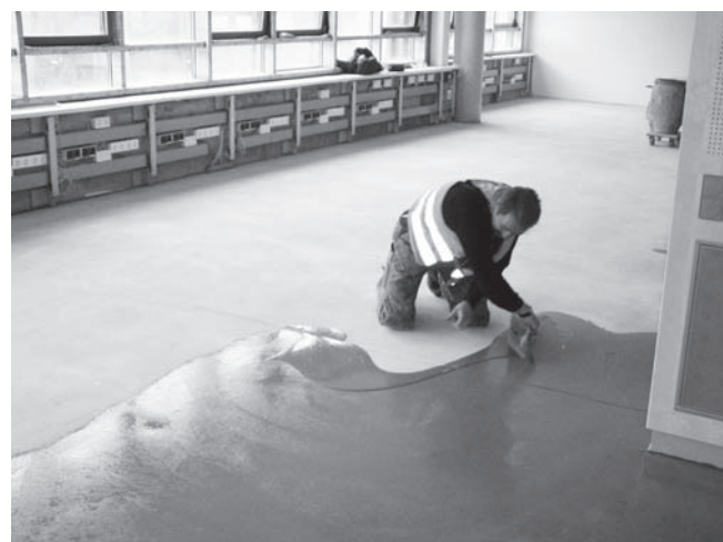
Abbildung C.22: Ausgleichsmasse mit Flächenspachtel auftragen
