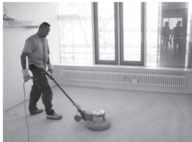
Abbildung C.12: Estrich mit Einscheibengerät abschleifen
