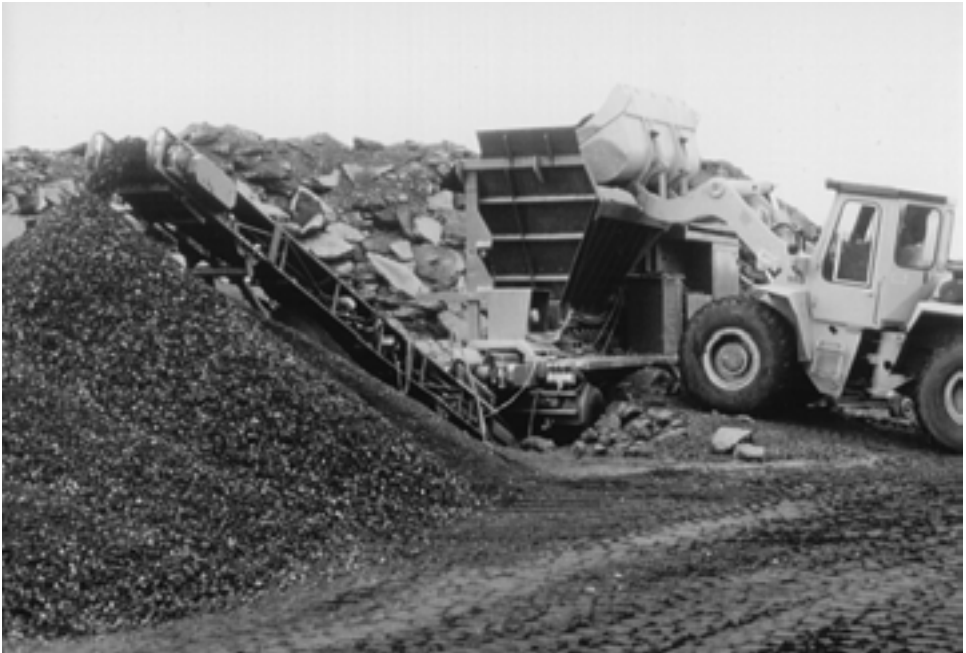
Abbildung 26: Brecherbeschickung beim Baustoffrecycling
