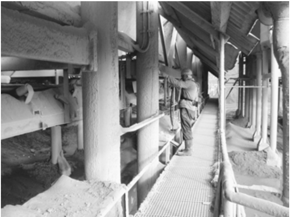
Abbildung 22: Kontrollgang im Bereich der Schotterumladung
