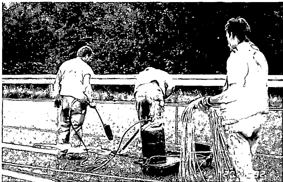
Abbildung 7: Mitgänger an der Markiermaschine (C4 9)
