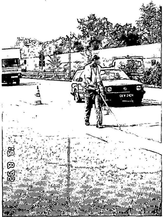
Abbildung 4: Leitlinie vorbereiten (C4 4)
