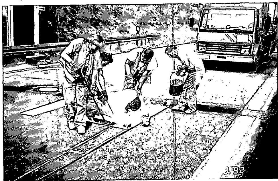
Abbildung 5: Richtungspfeil markieren (C4 5)
