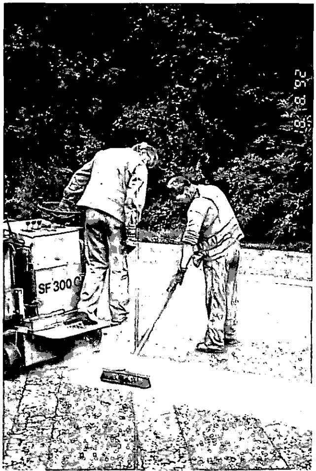
Abbildung 1: Mitgänger an der Straßenfräse (C4 1)
