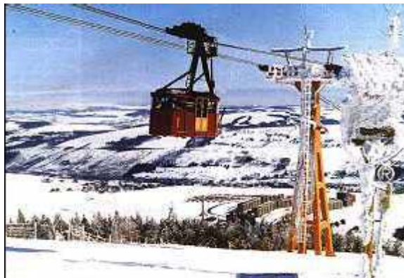
Abbildung 4: Kabine der Fichtelberg Schwebeseilbahn
