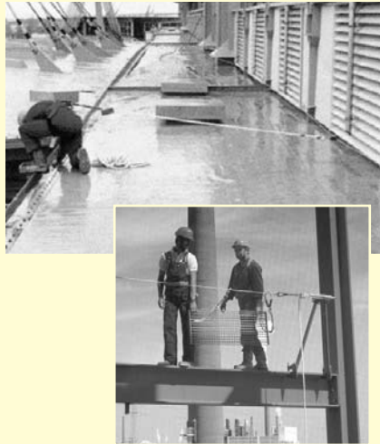
Abbildungen 3 und 4: Dacharbeiten, Montagearbeiten
