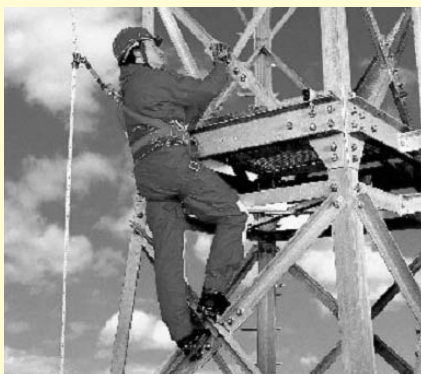
Abbildung 1: Mitlaufendes Auffanggerät einschließlich beweglicher Führung – vertikale Anordnung
