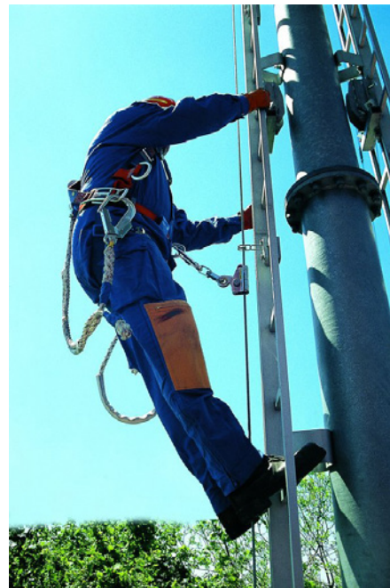
Abb. 1: Mitlaufendes Auffanggerät einschließlich Drahtseil als feste Führung
