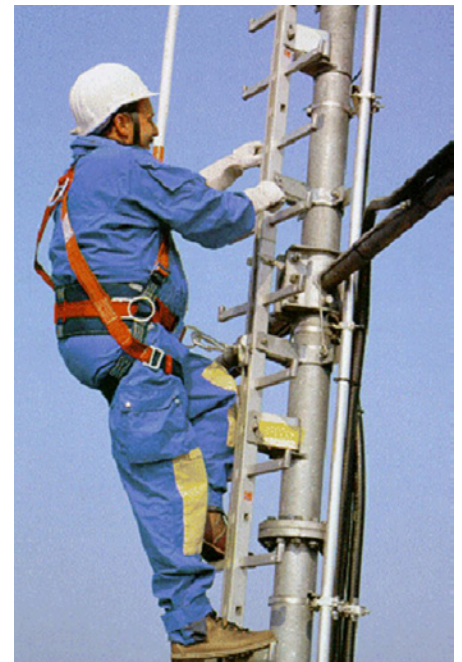
Abb. 2: Mitlaufendes Auffanggerät einschließlich Schiene als feste Führung
