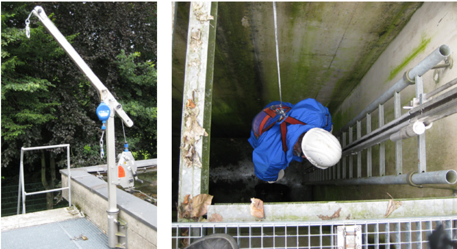
Abb. 3a und 3b: Beispiel für eine Sicherung mittels Höhensicherungsgerät an einem Schachteinstieg (Quelle: Autor)
