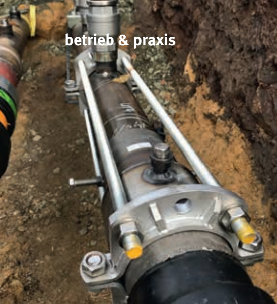
Abbildung 3: Einbau eines Überschieber in Rohrleitung – Z – Verlauf (Fa. Hütz+Baumgarten GmbH)
