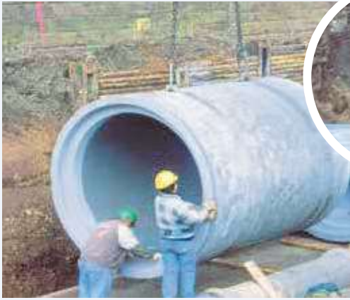
Anker im Scheitel des Rohrs
