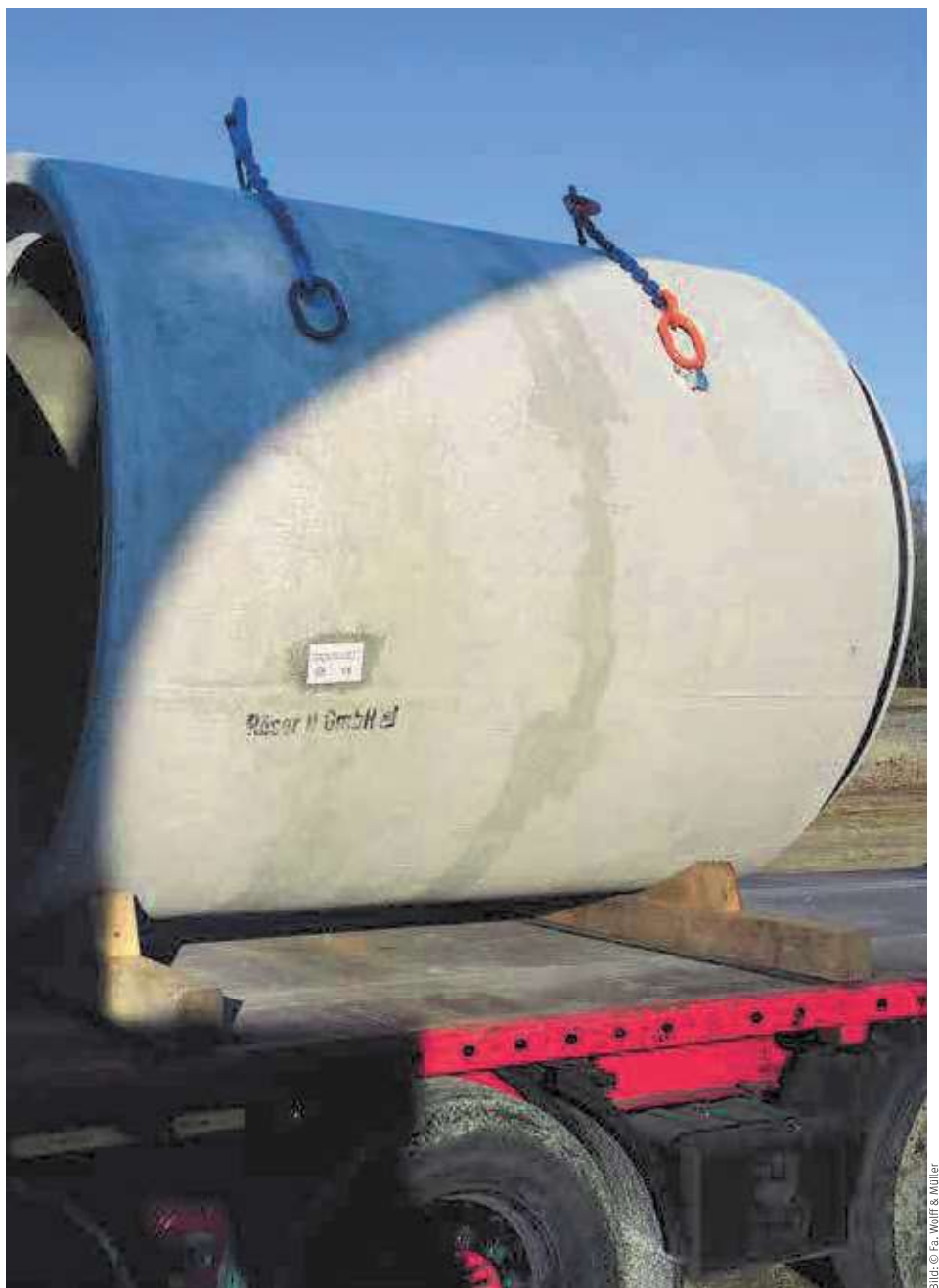
Großformatiges Rohr mit eingesetztem Anker
