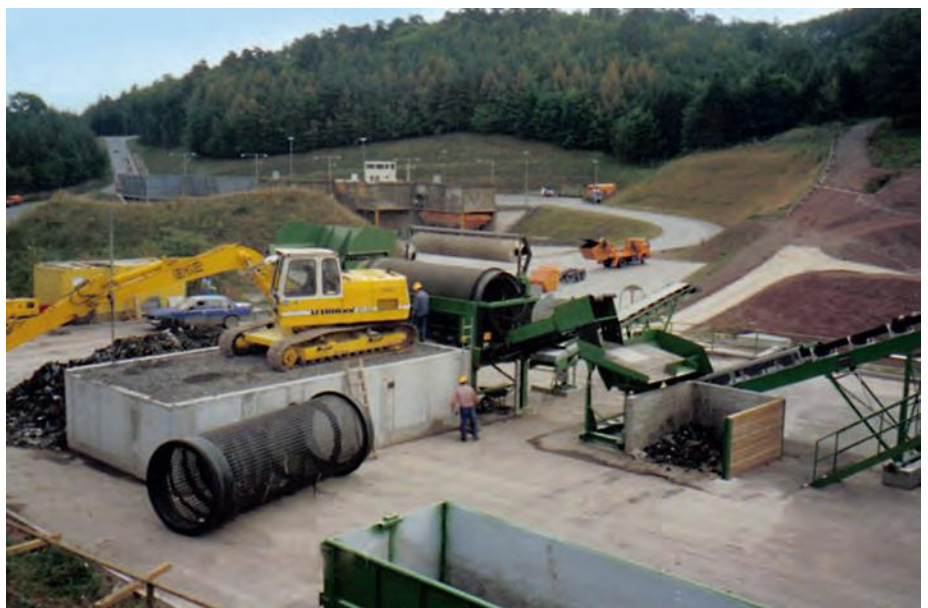
Abb. 6: Ortsfest betriebener Bagger an der Altmüllübergabestelle
