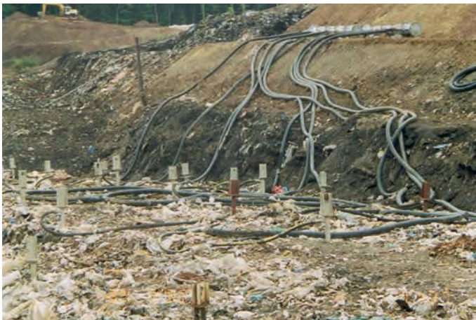
Abb. 3: Belüftungslanzen im Müllkörper
