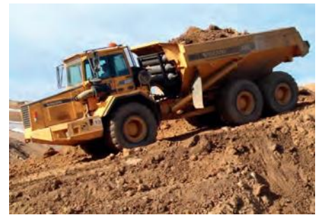
Abb. 5: Dumper mit Atemdruckluftanlage
