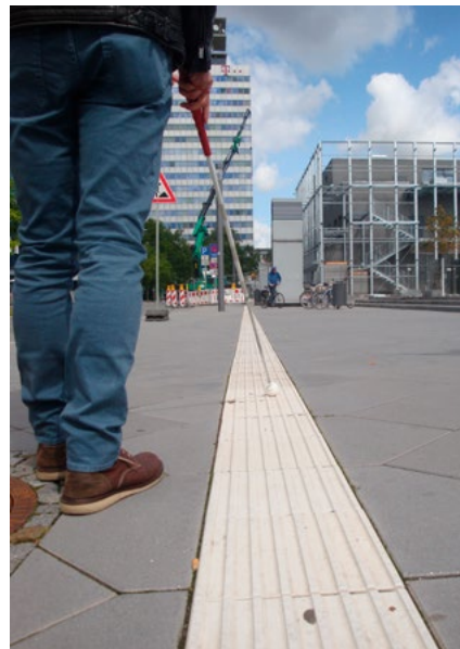
Abb. 1 Taktile und visuell erfassbare Bodenindikatoren
