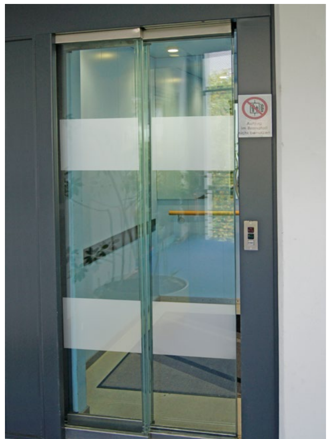
Abb. 1 Aufzug mit Markierungen auf Glasflächen
