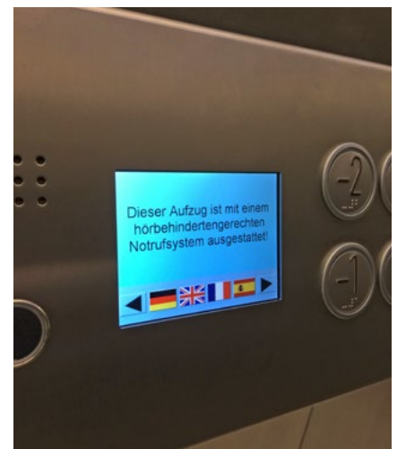
Abb. 10 Notrufsystem nach dem Zwei-Sinne- bzw. Zwei-Kanal-Prinzip
